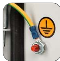
Обмедненные шпильки. Закрепленный поводок заземления
