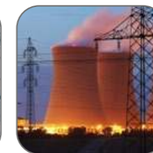
Объекты энергетической отрасли
